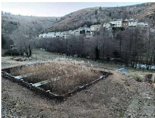
Station d'épuration communale
